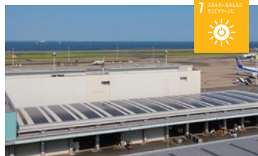
東京国際空港国内貨物ターミナル上屋に太陽光パネルを設置
