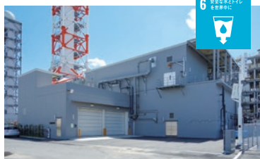
東京国際空港SDプラント
