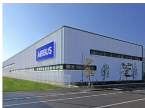
神戸空港格納庫 増築棟
