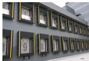
アークビル機内食工場
