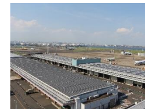
羽田空港国内貨物ターミナル 太陽光発電設備
