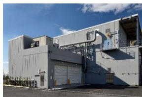
羽田空港新SDプラント
