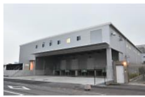
テクニカルセンター倉庫棟
