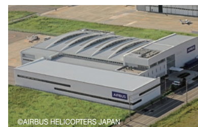
神戸空港格納庫 Kobe Airport Hangar
