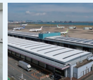
太陽光発電施設 (東京国際空港) Solar Power Generation Facility (Tokyo International Airport)
