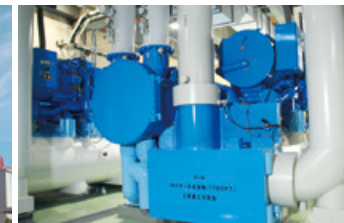
高効率電動ターボ冷凍機 High-efficiency Electric Turbo Chiller
