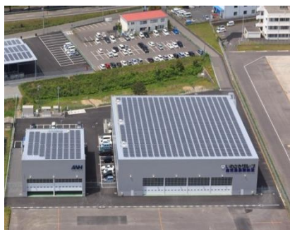
【鹿児島格納庫 屋上太陽光パネル】
