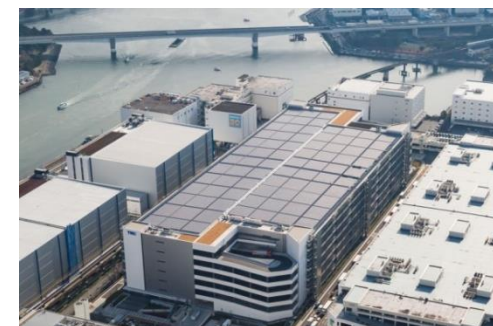
【TRC物流ビルB棟屋根ソーラー発電所】
