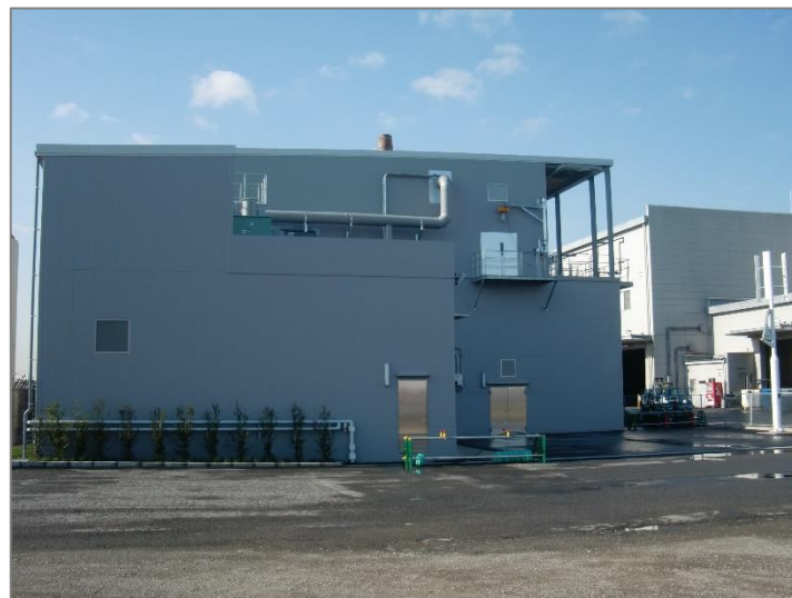
外観(工事中写真) 2019年10月撮影
