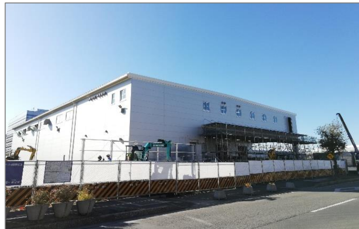
外観（工事中写真）
