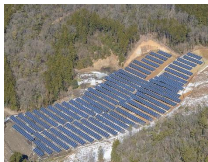
【岐阜瑞浪ソーラー発電所】
