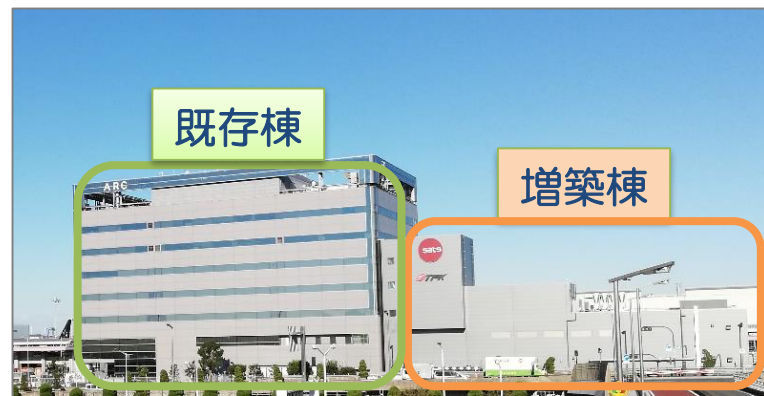
外観（工事中写真）
