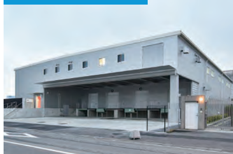
テクニカルセンター倉庫棟
