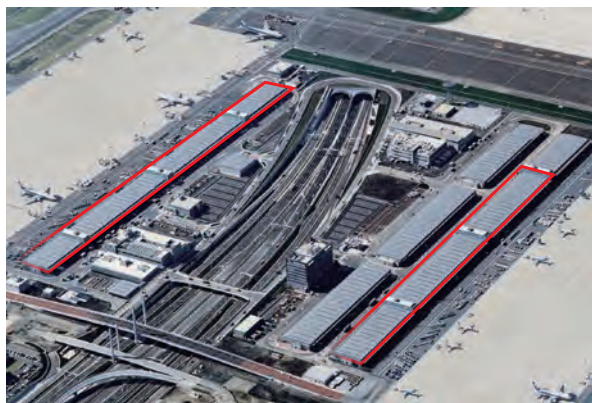
赤枠：太陽光パネル設置
