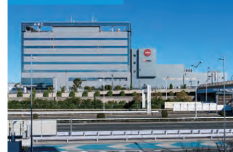
アークビル機内食工場
