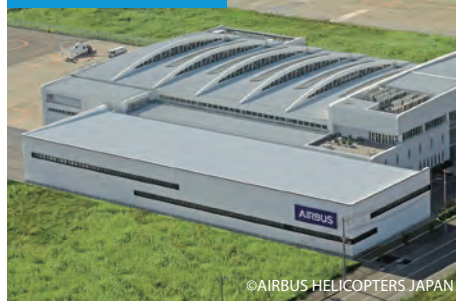
神戸空港格納庫増築
