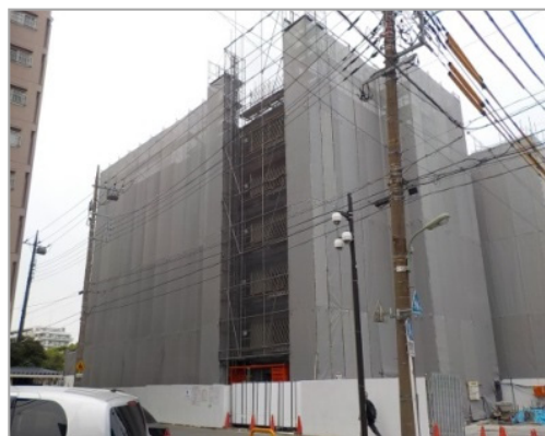
スカイレジデンス大鳥居（建設中）
