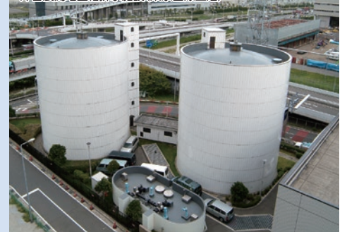
沖合展開地区給排水施設(東京国際空港)
