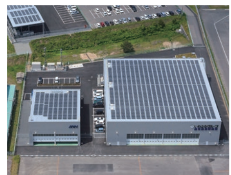
鹿児島空港格納庫 屋上太陽光パネル
