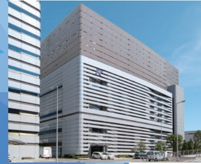
エネルギーセンター
