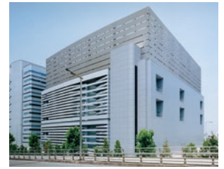
エネルギーセンター
