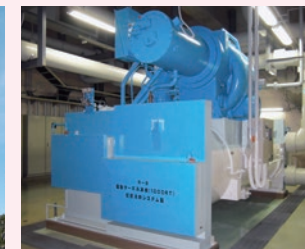
高効率電動ターボ冷凍機 High-efficiency Electric Turbo Chiller
