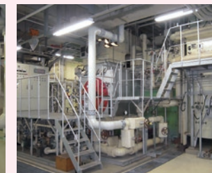
水管式ボイラー Water-tube Boiler
