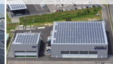
鹿児島空港第一・第二格納庫及び倉庫
