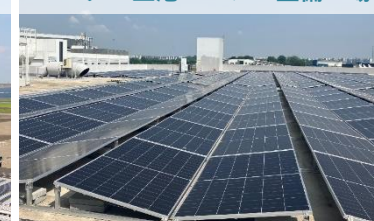
セレーン空港エンジン整備工場
