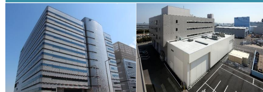
ユティリティセンタービル
