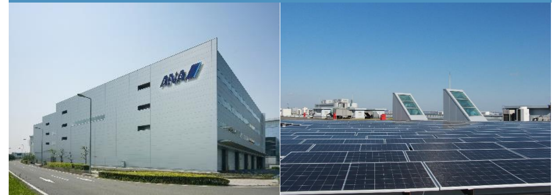
コンポーネントメンテナンスビル
