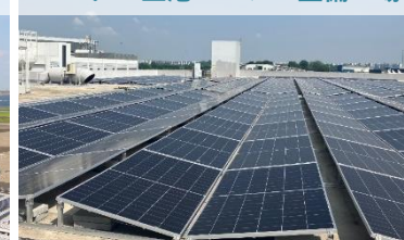
セレーン空港エンジン整備工場
