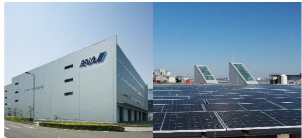
コンポーネントメンテナンスビル
