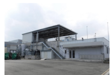
大型航空機洗機施設
