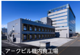
アーキビル機内食工場
