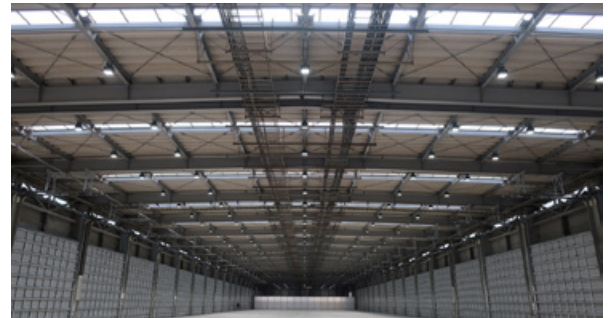
国内貨物ターミナル施設W-1棟
