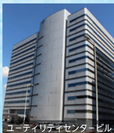
ユーティリティセンタービル
