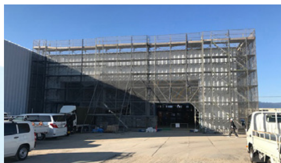
神戸格納庫増築工事
