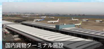
国内貨物ターミナル施設
